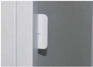
Opěra v prostoru zámku XMWAFL
